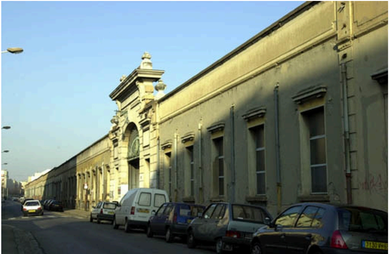
Détail travées de la façade Feuillat
