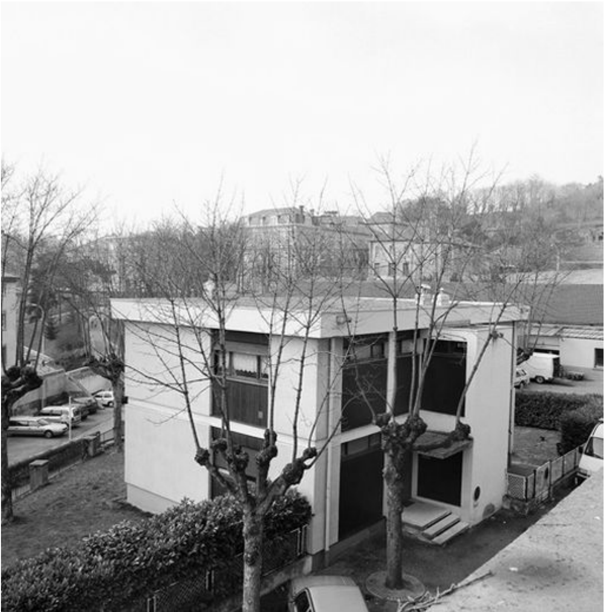
Pavillon de logements (31), vue générale sur l'angle nord-est
