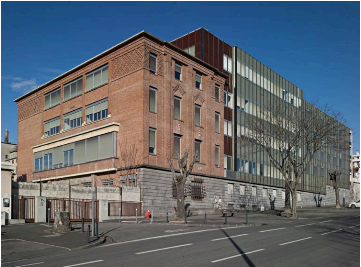
Hôtel-Dieu de Clermont-Ferrand. Le pavillon des maladies sociales vu du sud-est (avenue Vercingétorix) et les façades orientales des bâtiments des laboratoires et de gastro-entérologie.
