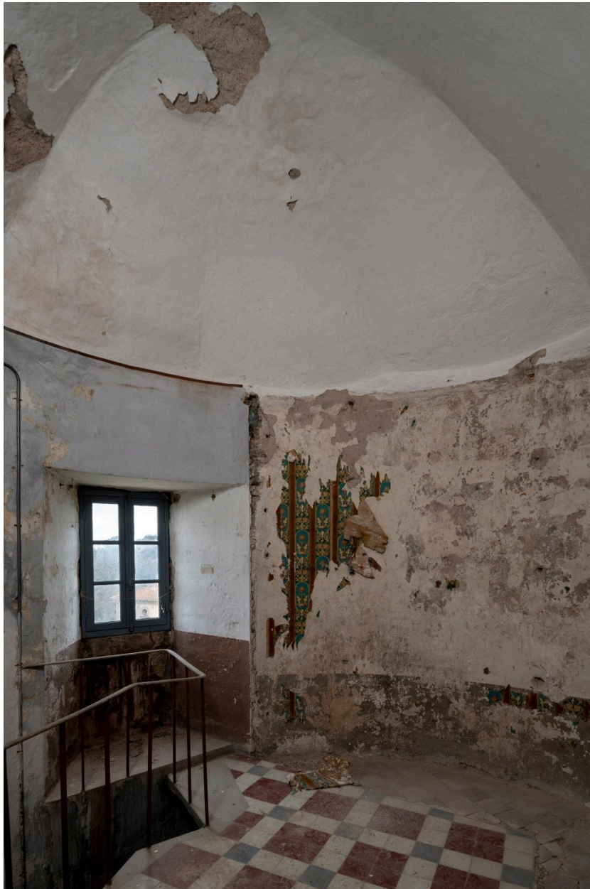
Châtelet, tour sud, rez-de-chaussée : vue d'ensemble du dernier niveau
