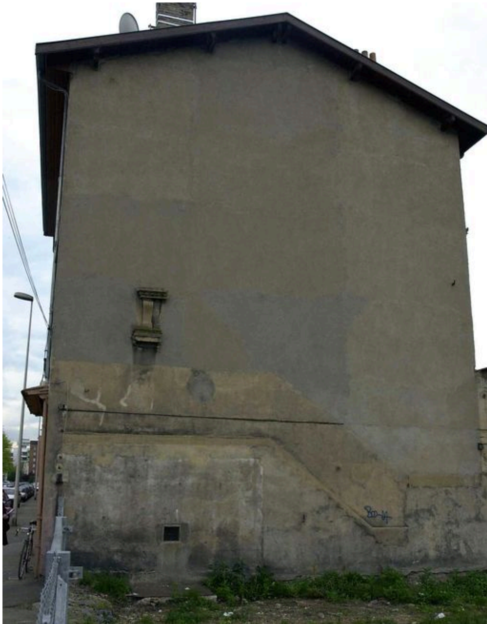
Vue du pignon nord
