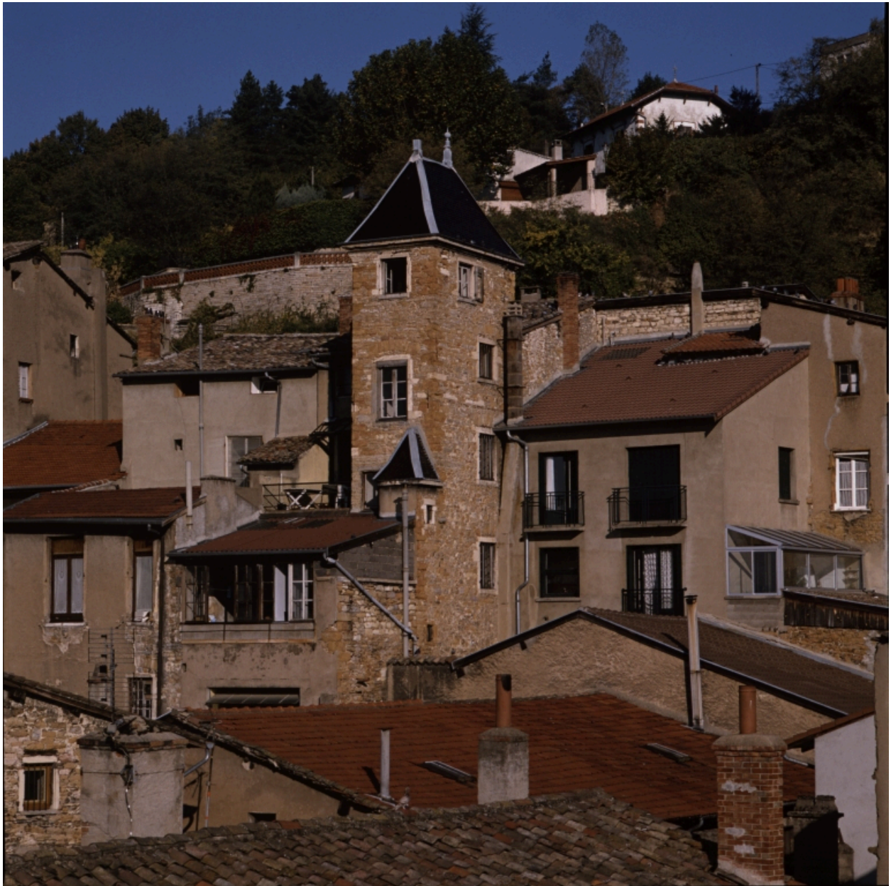
Maison de type IV, 1 rue de l'Herberie : élévation postérieure et lanterne d'escalier
