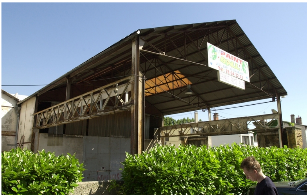
Hangar et charpente métallique
