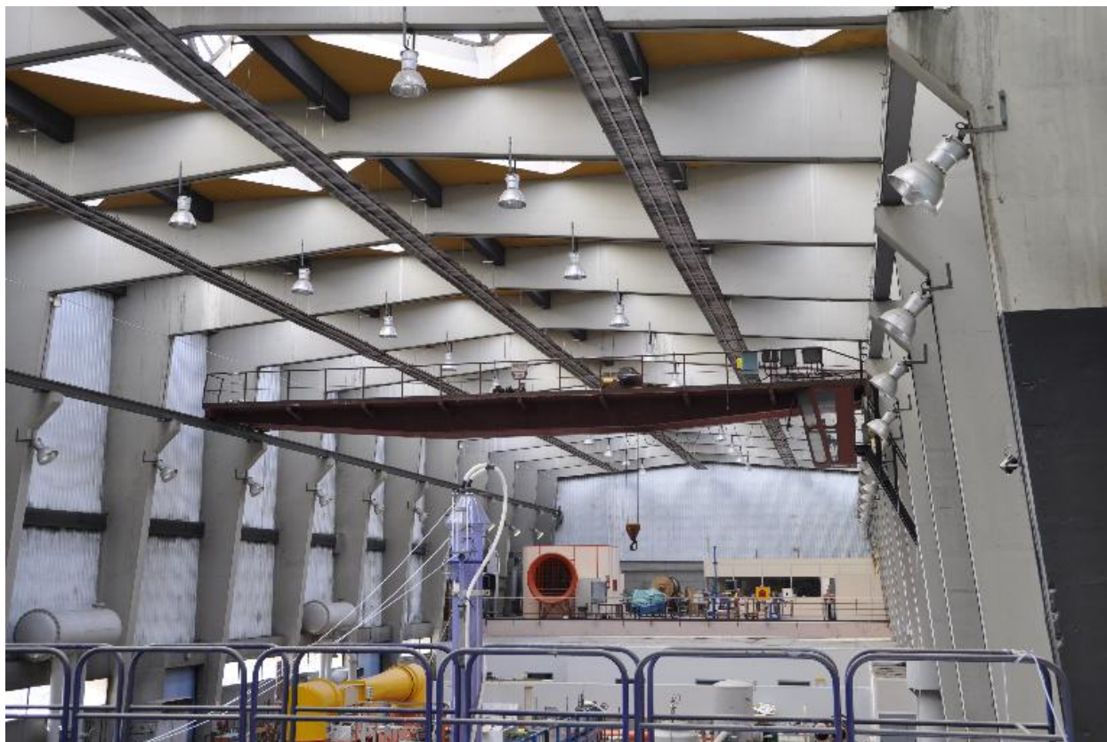
Vue de l'intérieur de la halle
