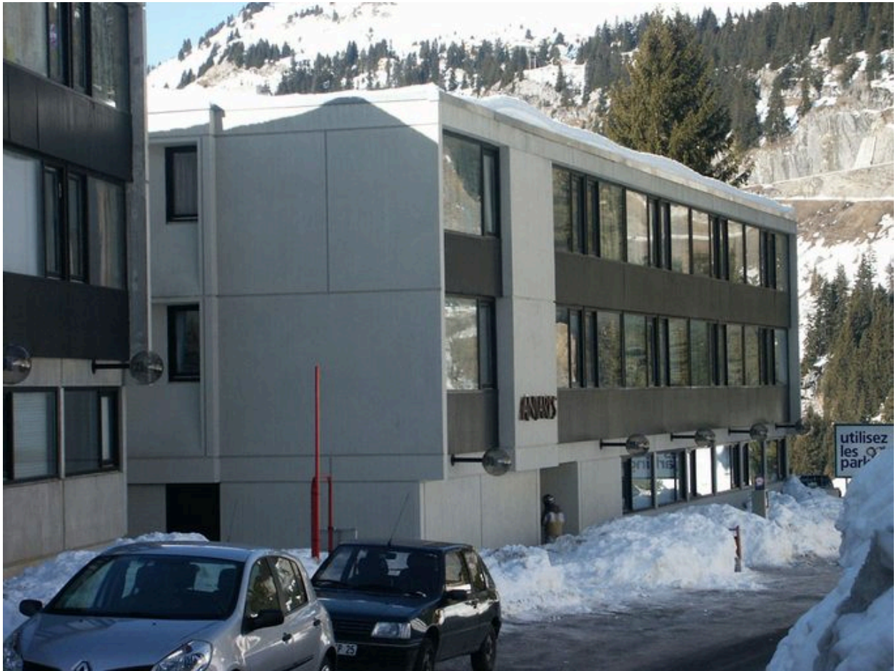
Vue depuis le nord-est
