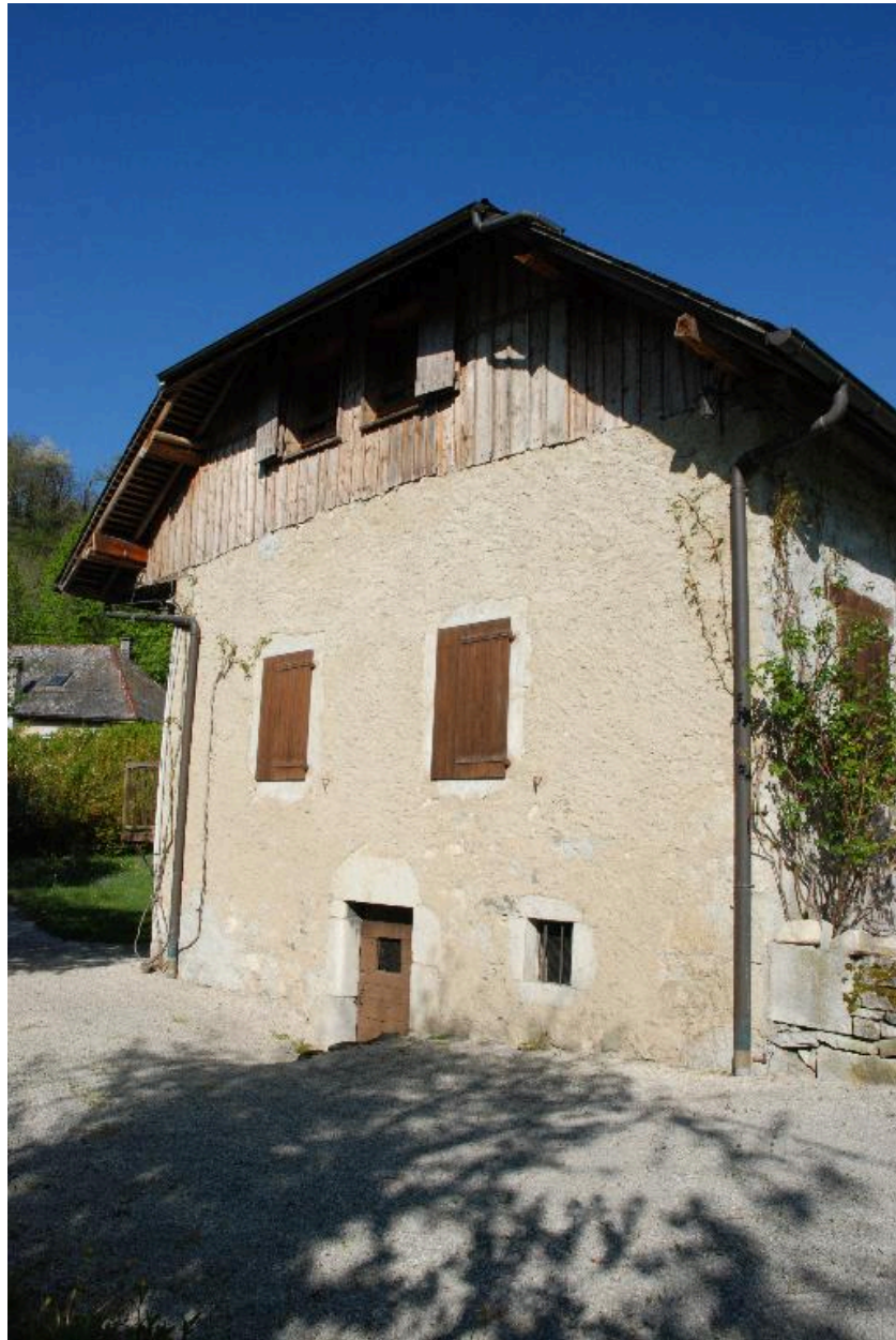
Vue d'ensemble du mur pignon est, entrée du moulin au centre.
