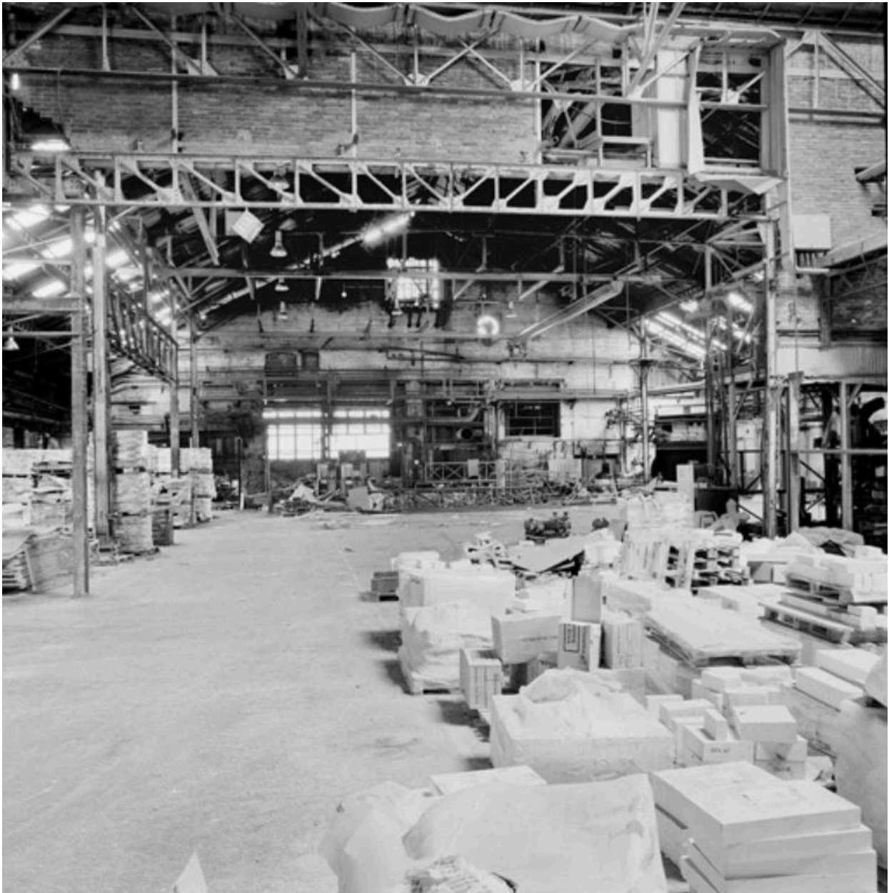
Vue intérieur des stockages
