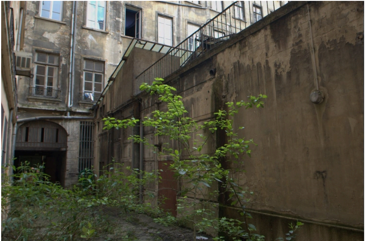
vue d'ensemble est
