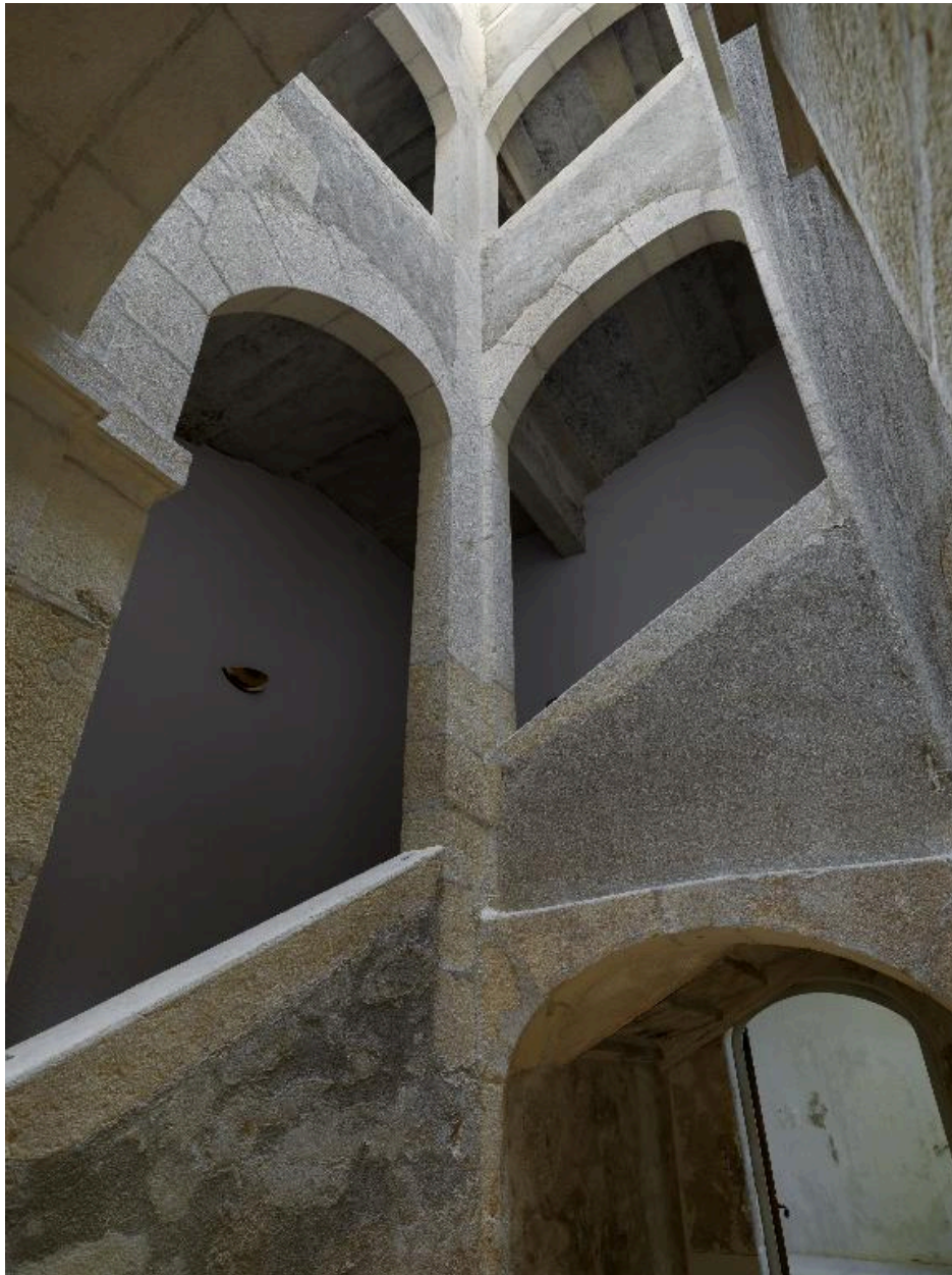
Vue d'ensemble de l'escalier à quatre noyaux
