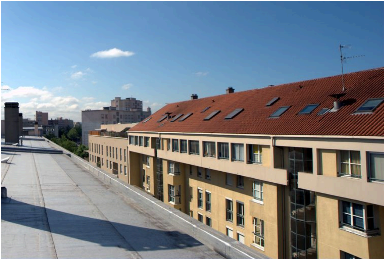
Élévation antérieure, niveaux supérieurs, depuis le nord
