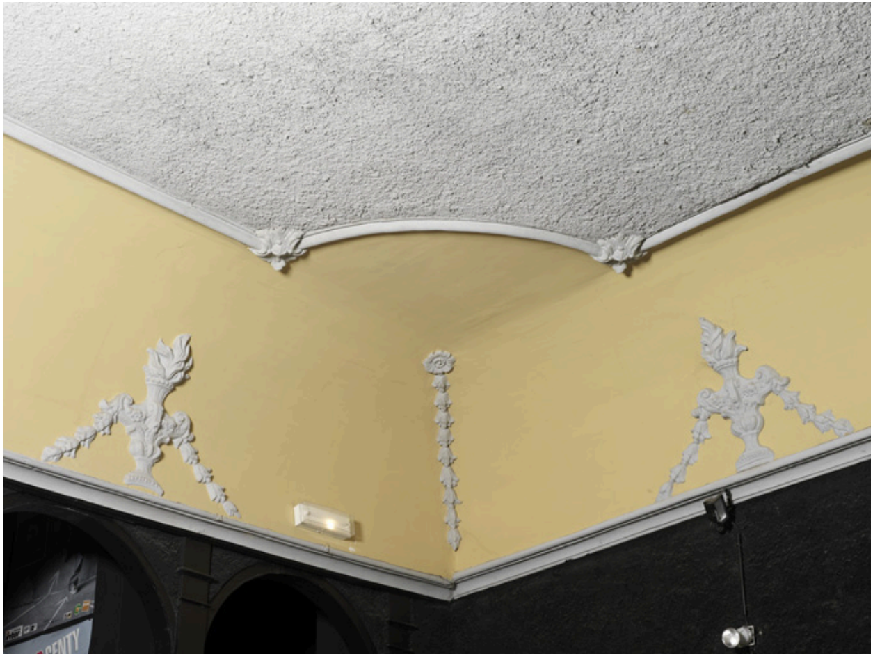
Corniche du plafond, détail : décor d'un angle.
