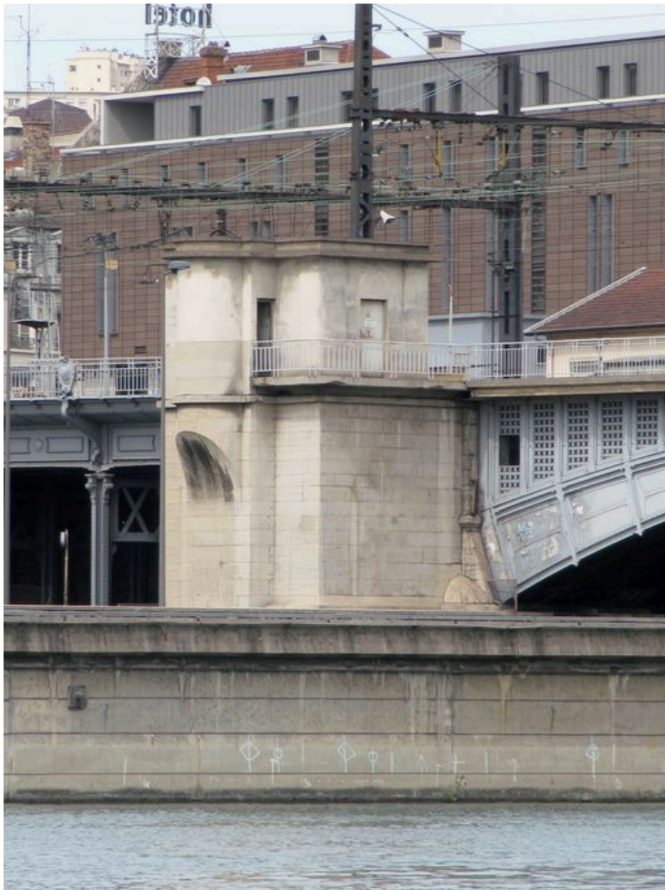
Culée droite, face aval, vue générale (depuis la rive gauche)
