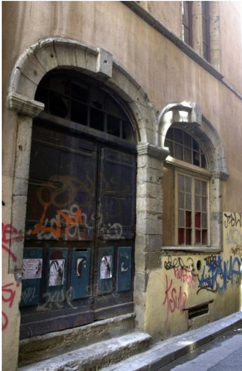
Façade sur la rue du Major-Martin, ouvertures de boutique
