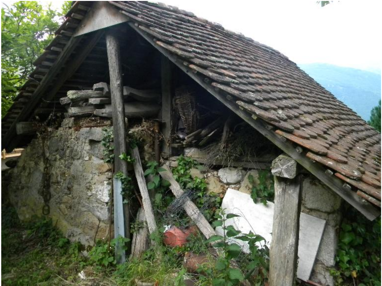
Vue de la façade arrière.
