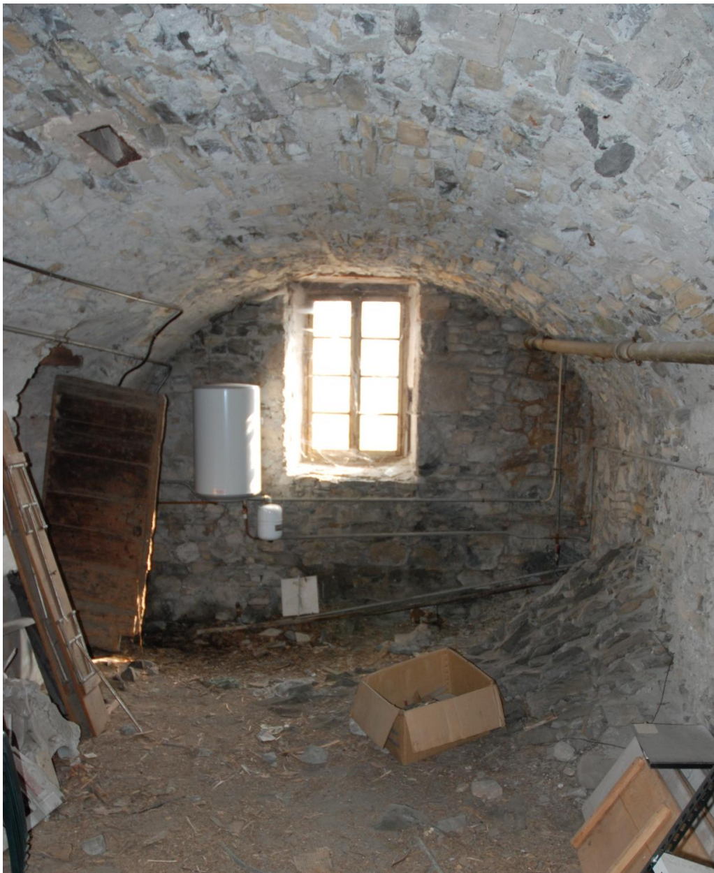
Vue intérieure de l'étage de soubassement, 3e travée de cave ; à droite, l'extrados de la voûte couvrant l'escalier d'accès au sous-sol.
