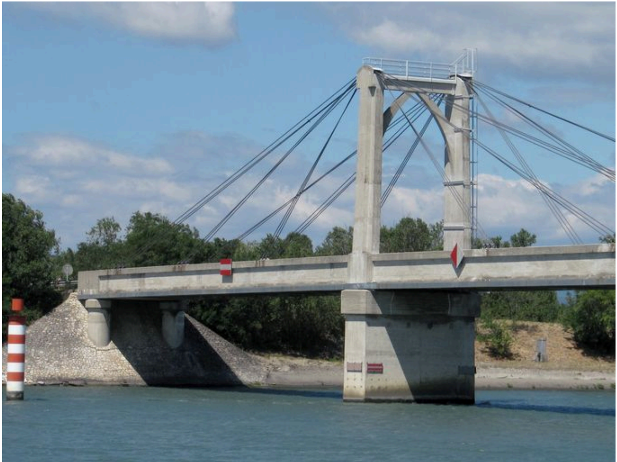
Travée de rive droite, face aval (depuis la rive gauche)
