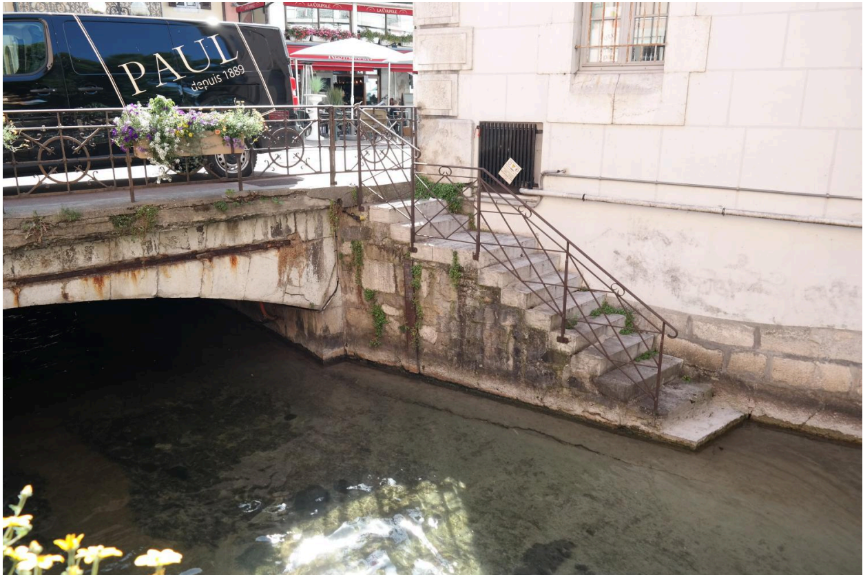
Pont des Cordeliers, escalier en pierre en aval
