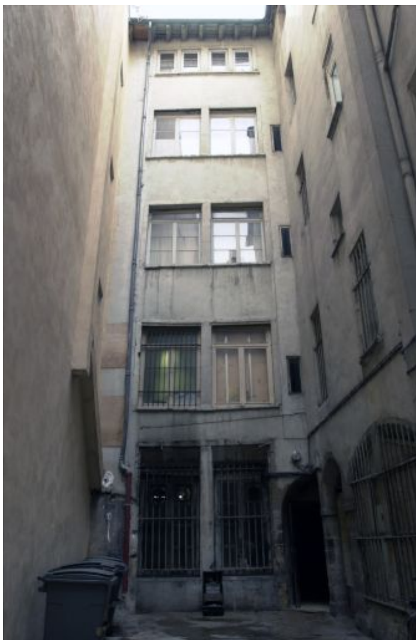
Grande cour I, élévation du bâtiment 3
