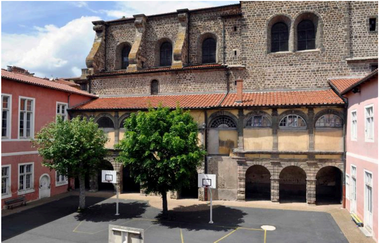
Cour 3, vue d'ensemble depuis le sud
