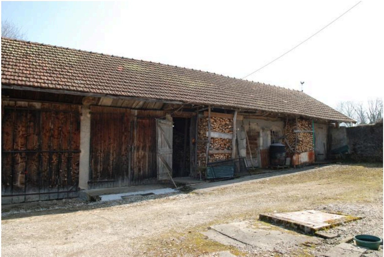
Vue d'ensemble du bâtiment avec granges, logement et ancien four à pain.
