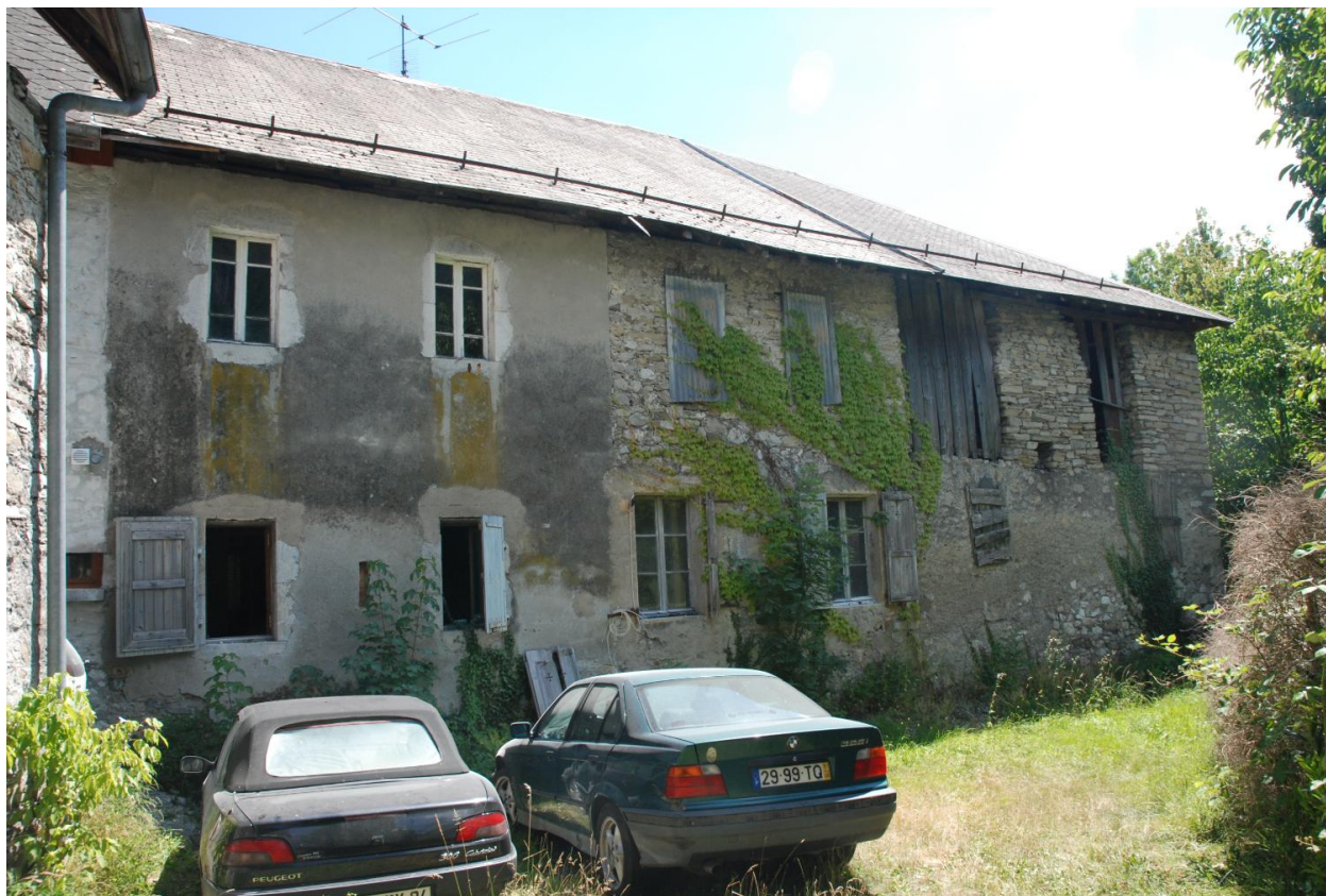
Maison de vigneron (2018 I1 196), élévation postérieure.
