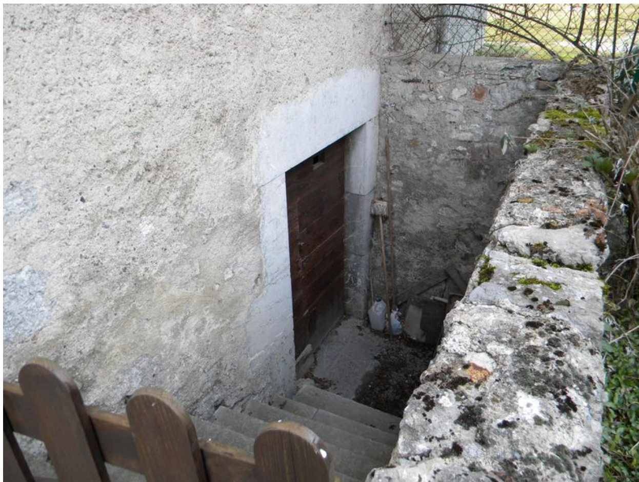
Descente de cave sous la dépendance nord.
