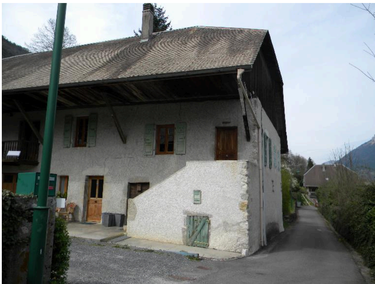
Vue de l'escalier maçonné en façade d'une ancienne ferme (2008 A3 405).
