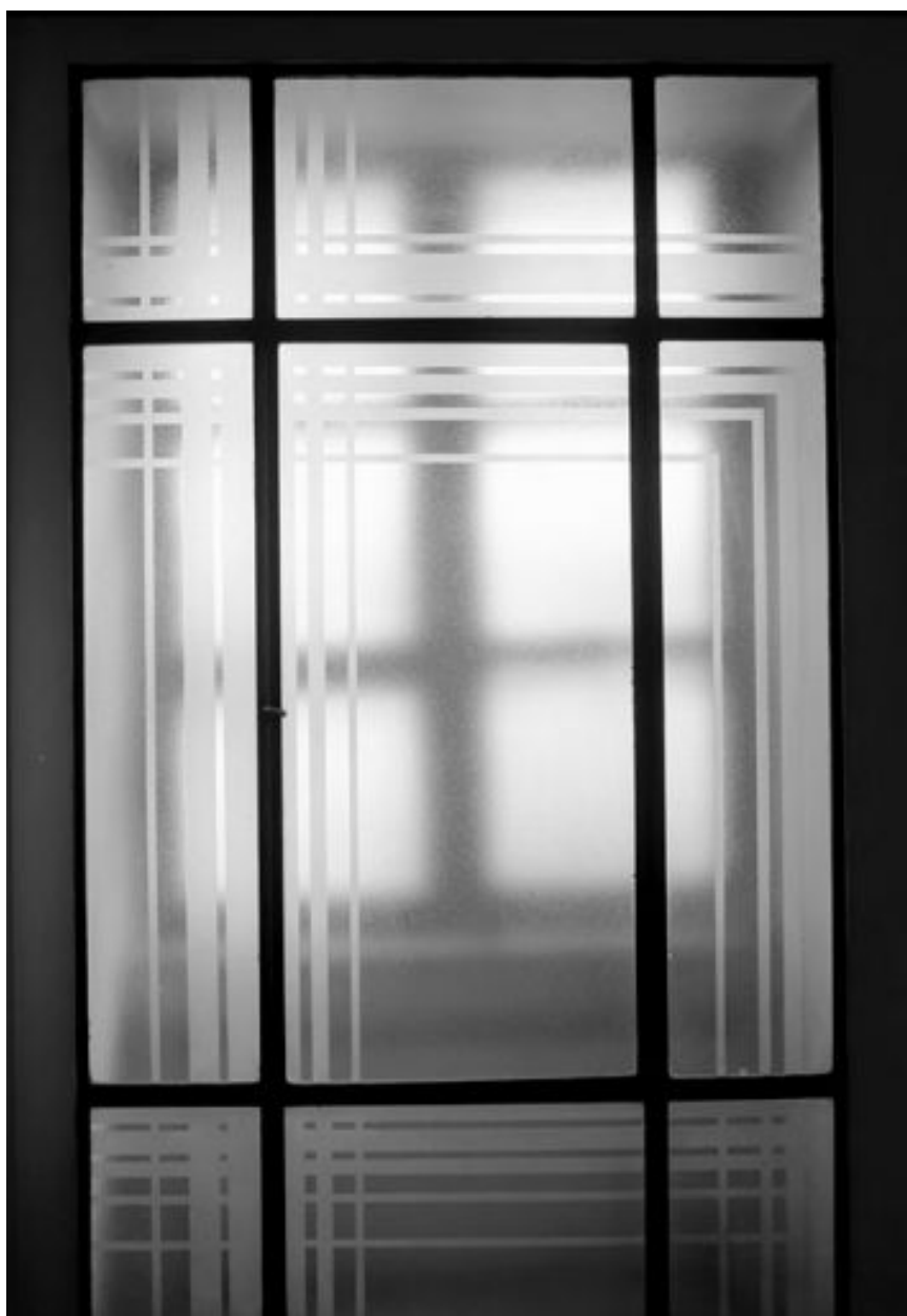
Fenêtre éclairant la cage du premier escalier
