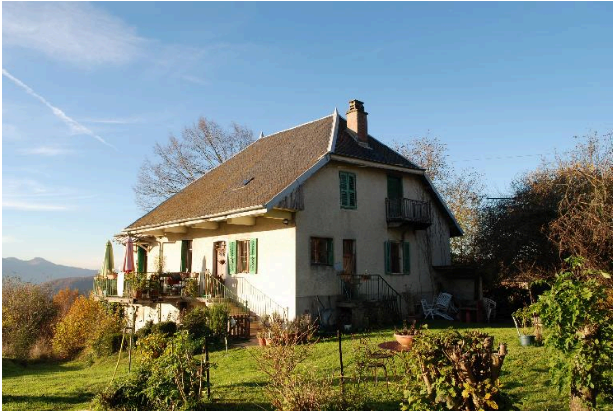
Cendres (les), maison, 2014 C3, 1713. Vue d'ensemble de trois-quarts.
