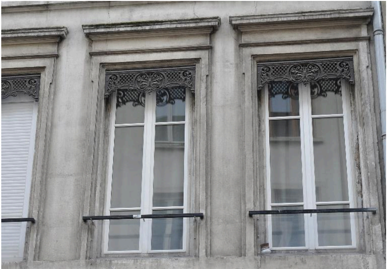
Vue rapprochée des fenêtres
