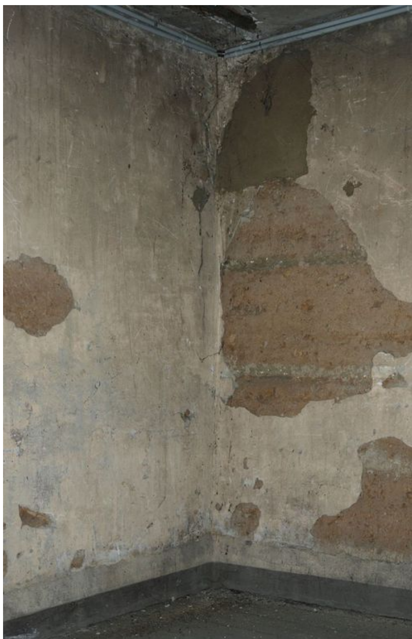
Etage de la boulangerie : mur en pisé
