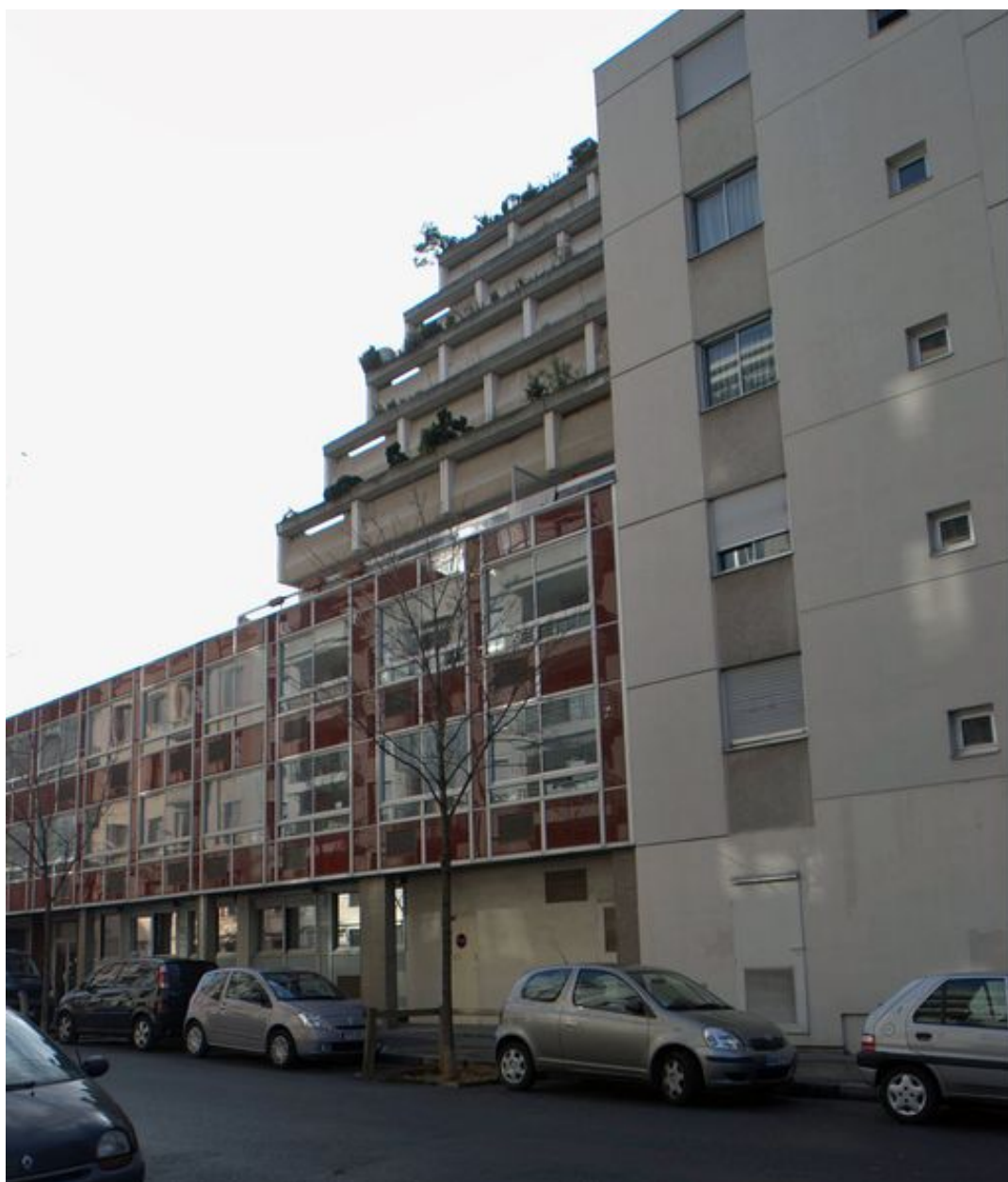
Elévation antérieure, depuis le nord, détail
