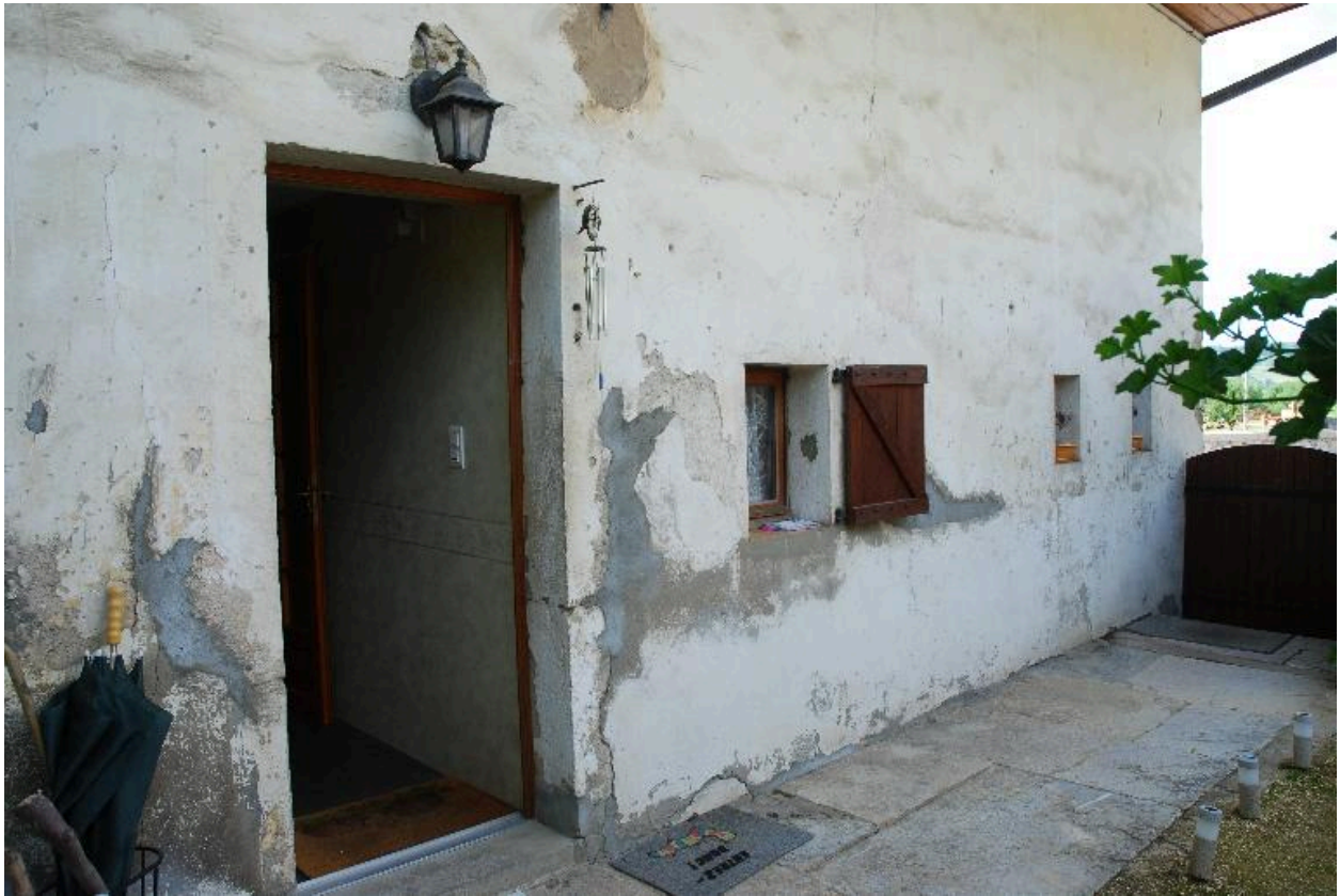
Façade est, vue partielle du rez-de-chaussée surélevé.
