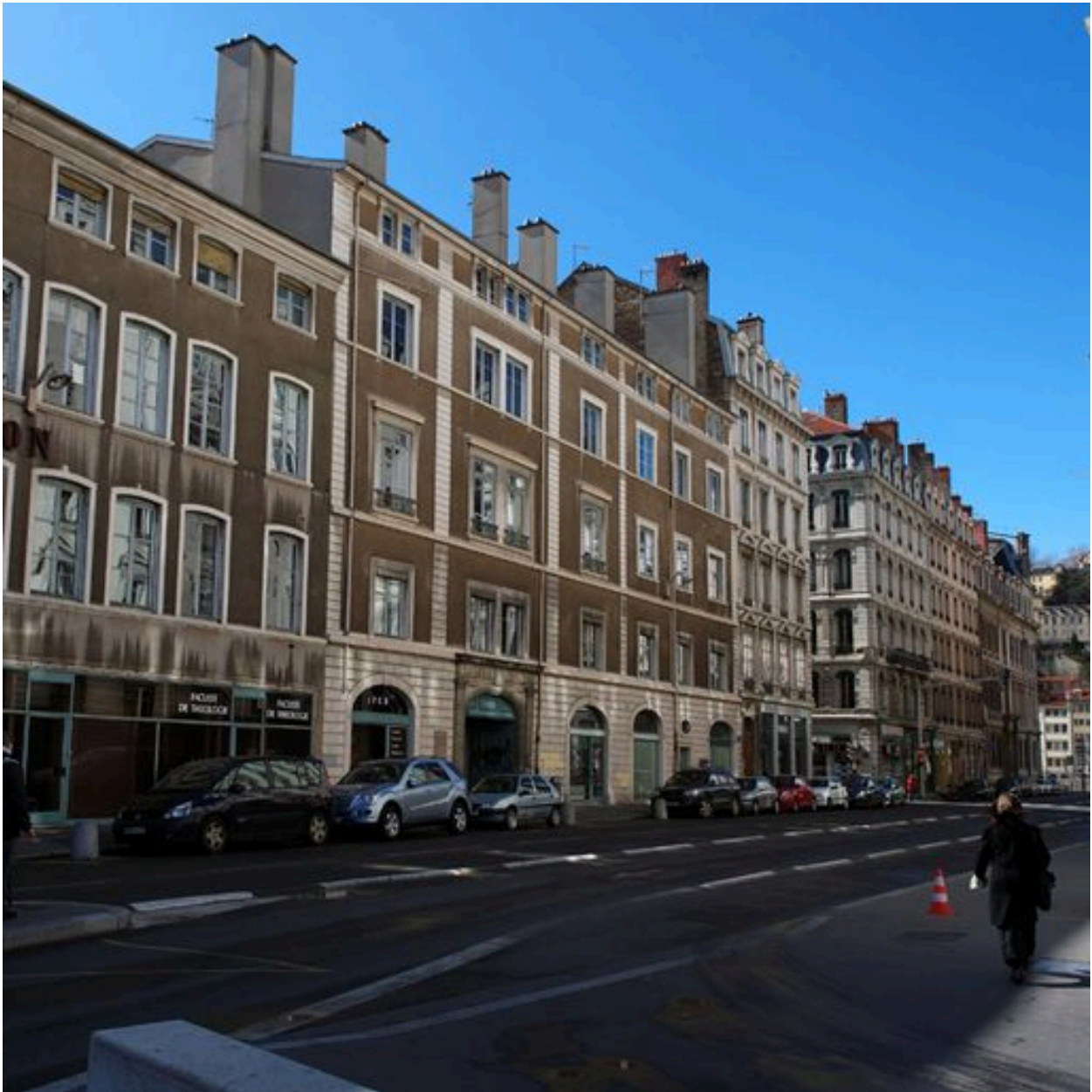
Vue de l'élévation antérieure depuis le nord-est
