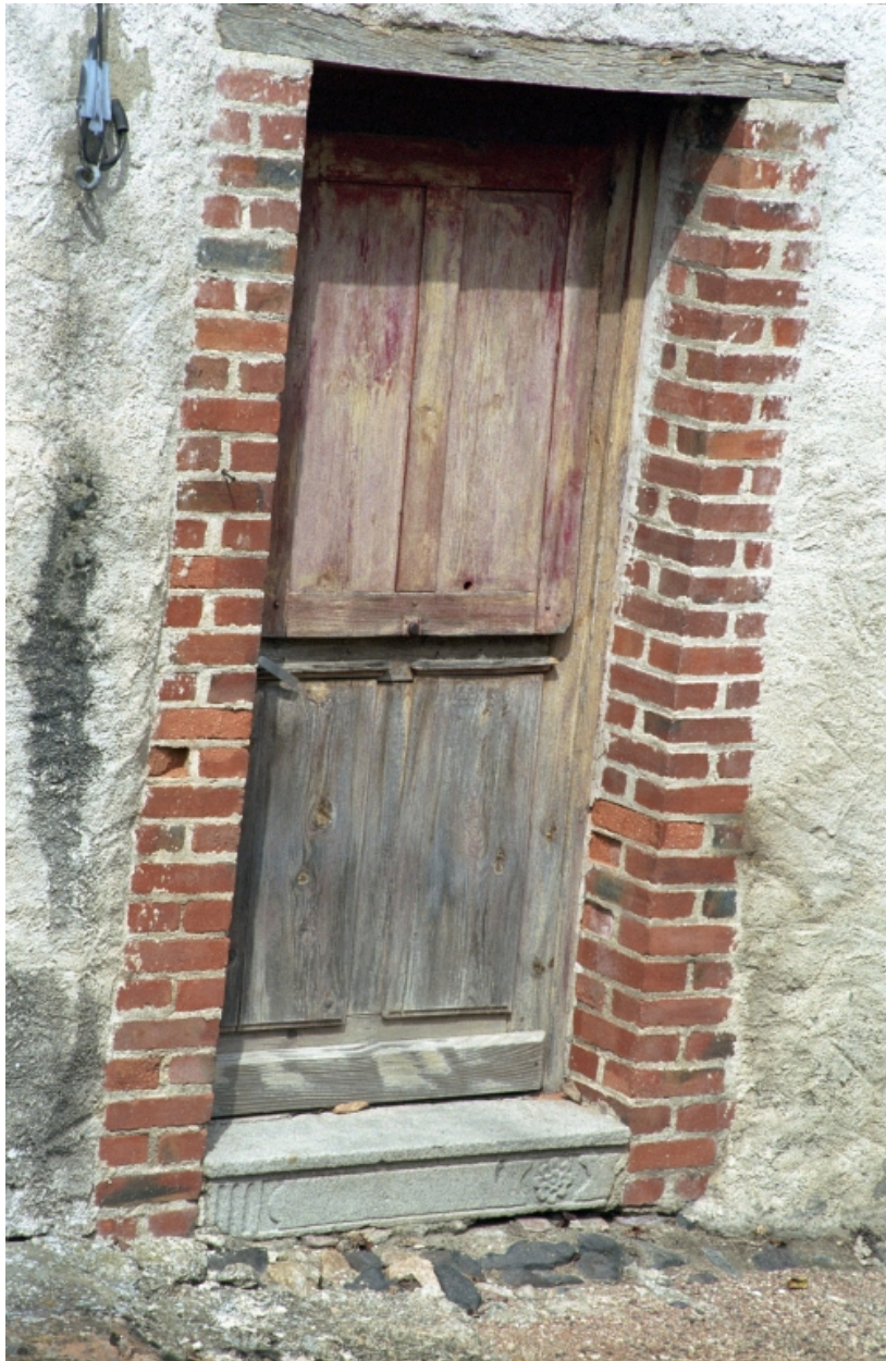
Montverdun, le Bourg (1986 B1 298), type A1. Détail de la porte d'entrée du logis : linteau de cheminée en pierre remployé comme seuil.
