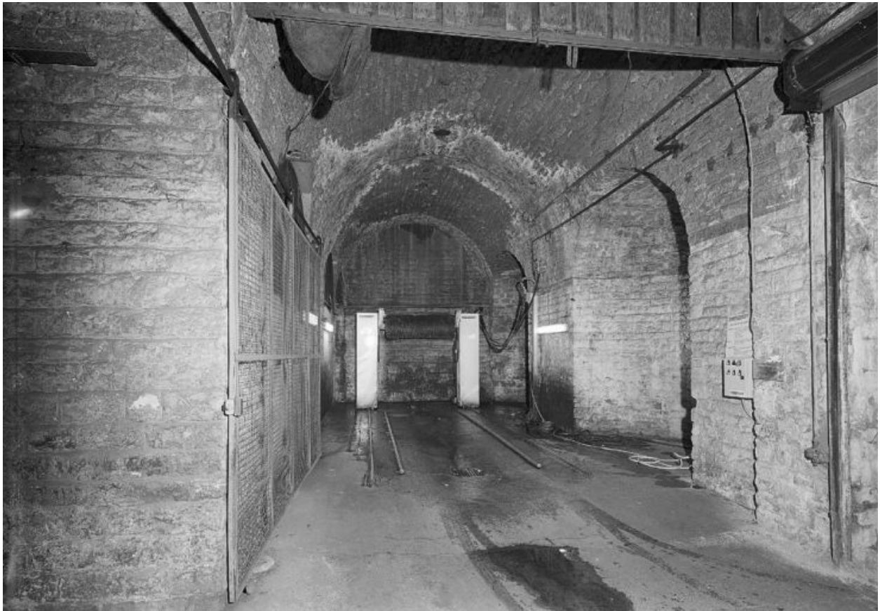
Le soubassement de la voie ferrée à l'est de la rue Delandine : vue d'une travée de remises parallèle à la rue Delandine
