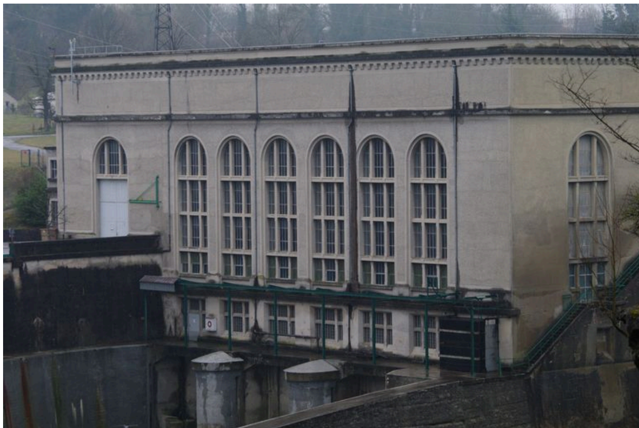
Elévation nord-ouest du bâtiment des machines
