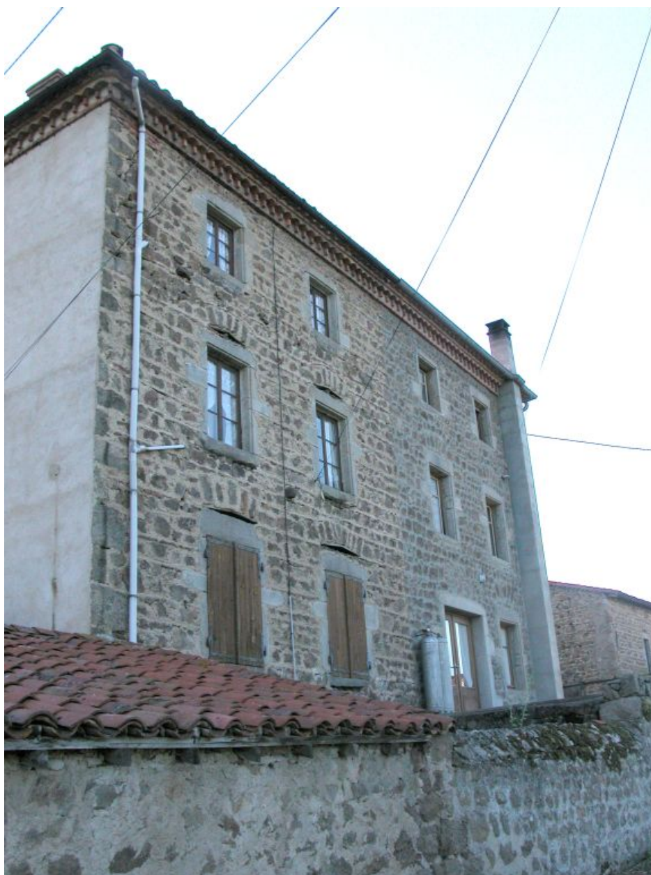
Elévation droite du logis de la ferme.
