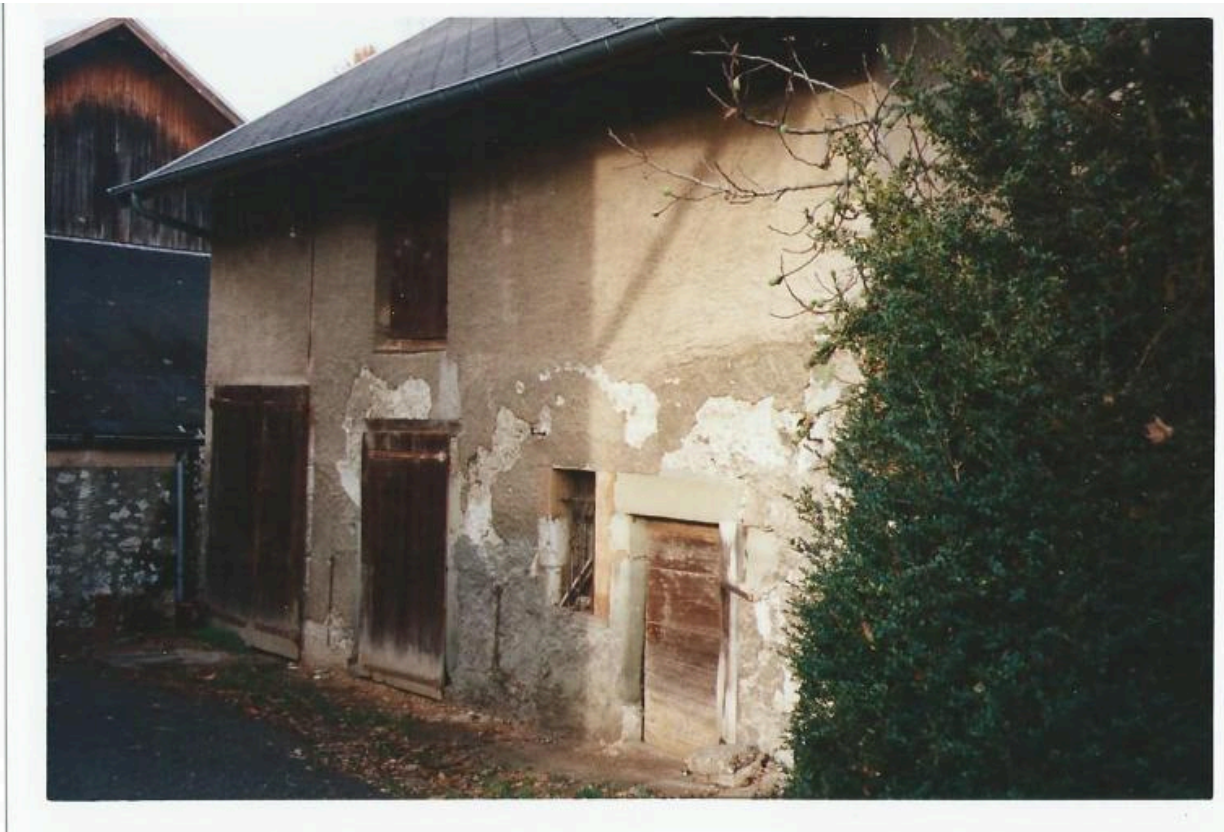
Façade sur rue de la grange, avant transformation, 1998
