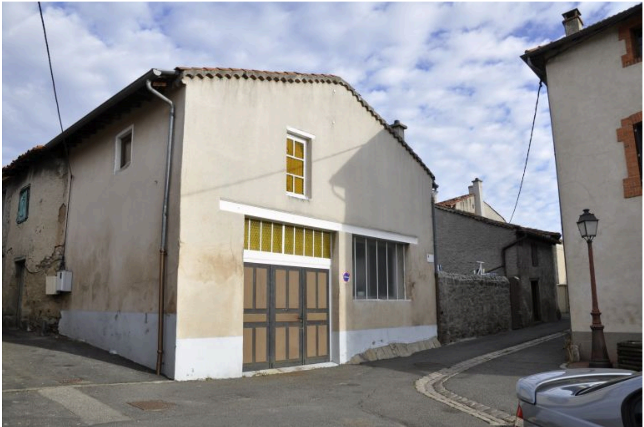
1986 AE 147, rue des Vignerons. Atelier usines Nourrisson puis GéGé, Vue d'ensemble.
