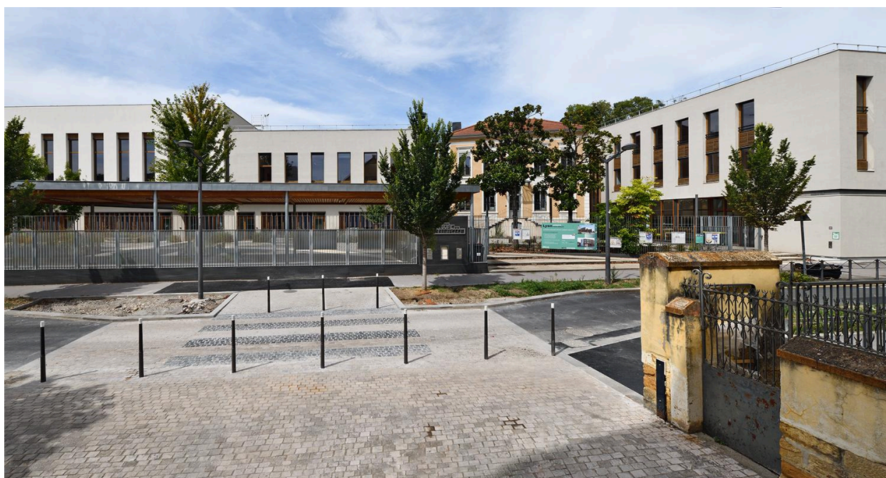
Rue des Docks, vue de situation, état en 2025
