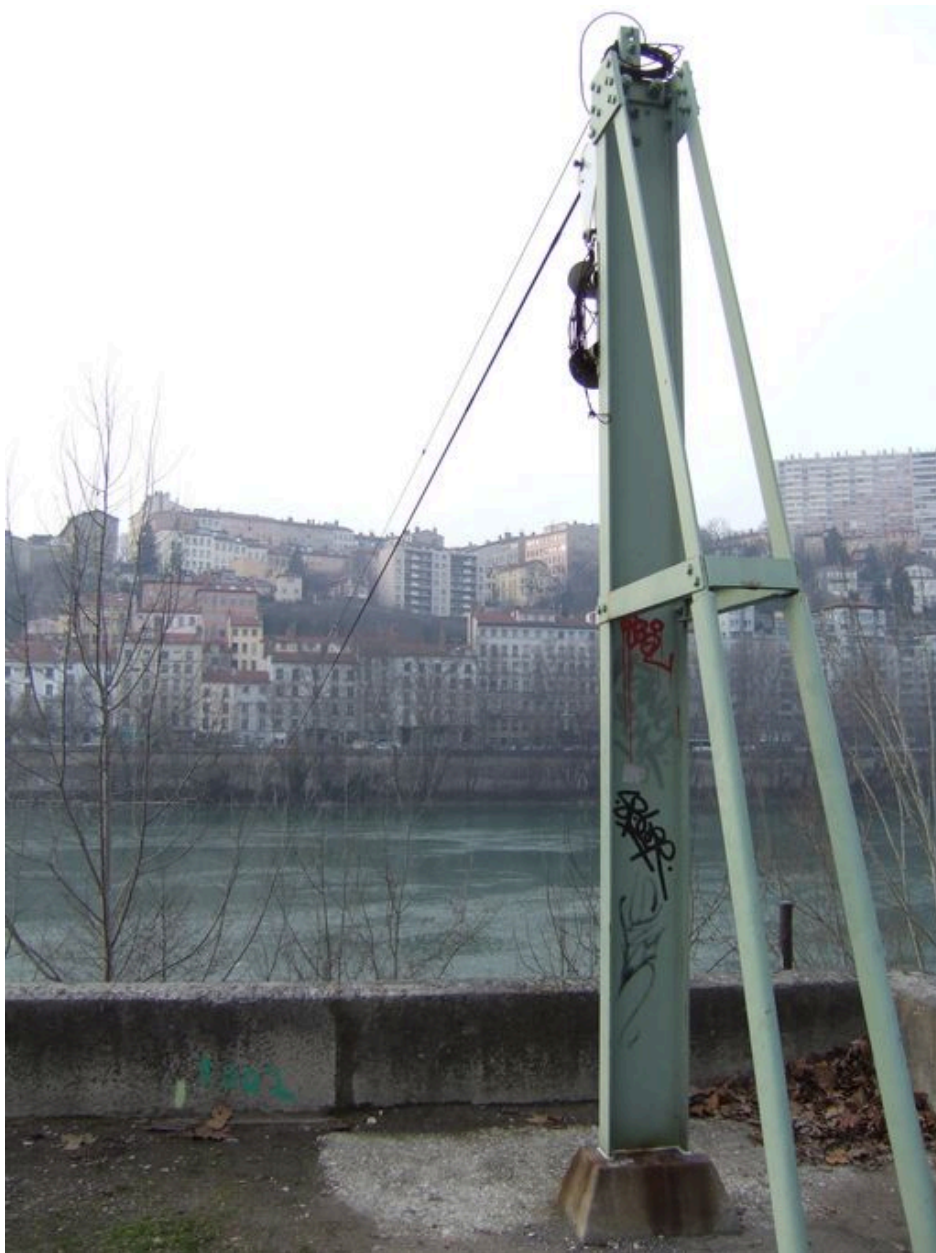
Structure métallique subsistante en rive gauche et câble tendu sur le fleuve
