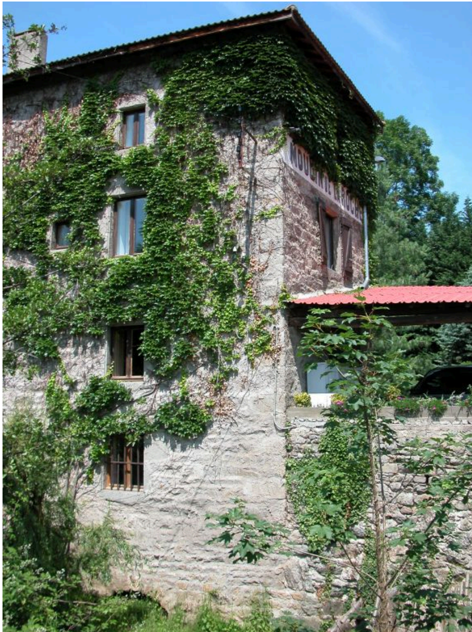
Premières travées de la façade sud-est du moulin
