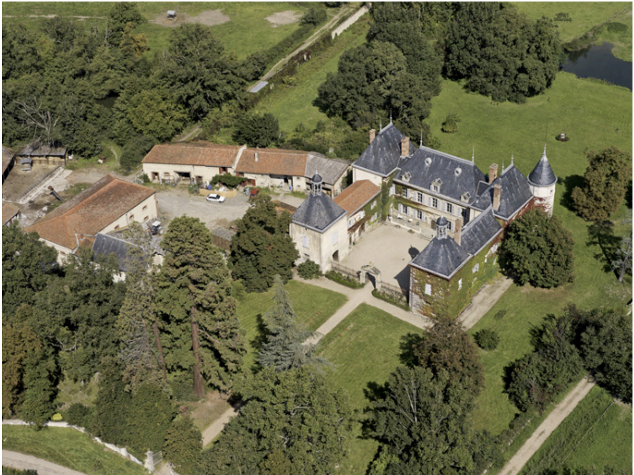
Vue d'ensemble aérienne depuis le sud-est.
