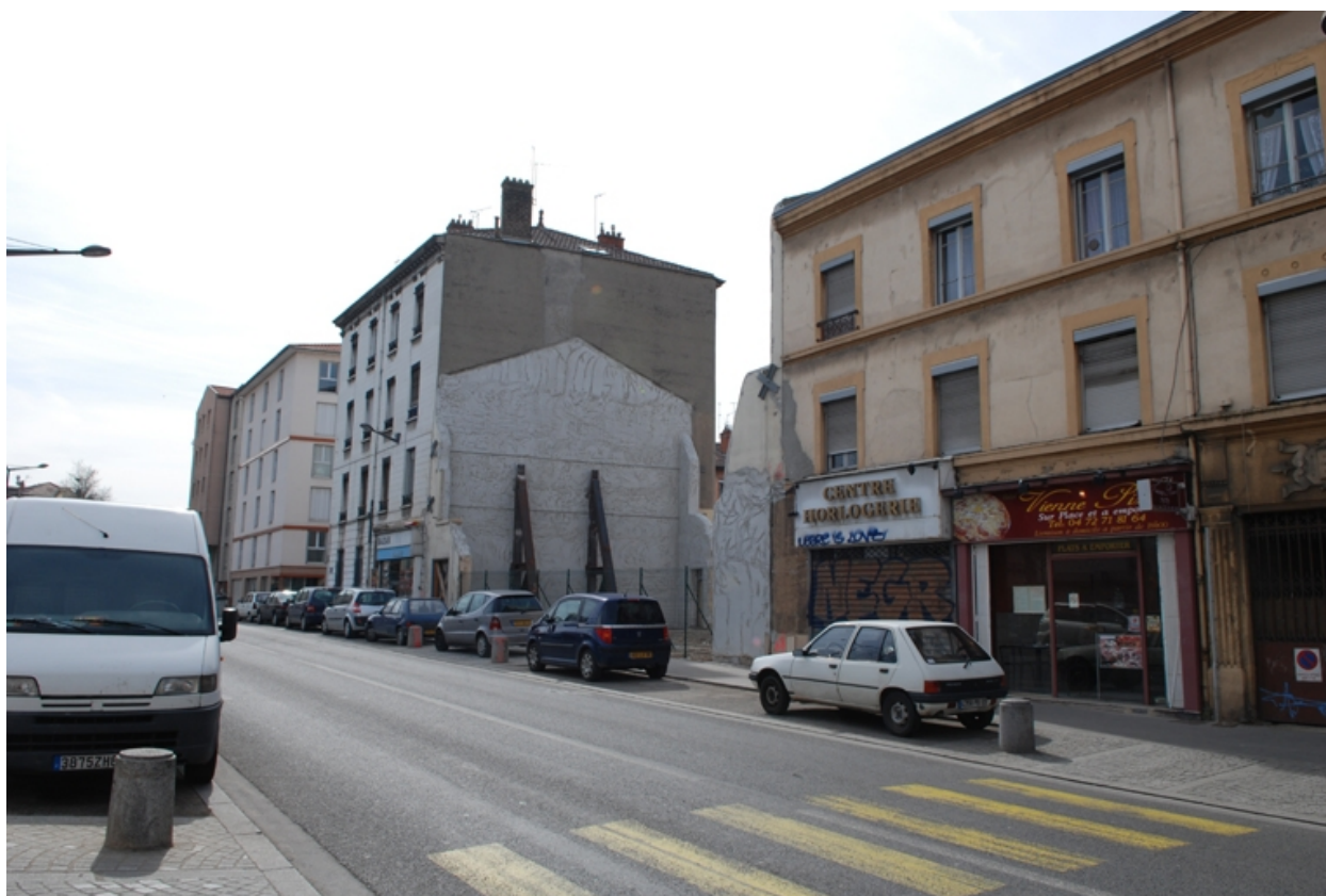
Vue nord façade sur rue
