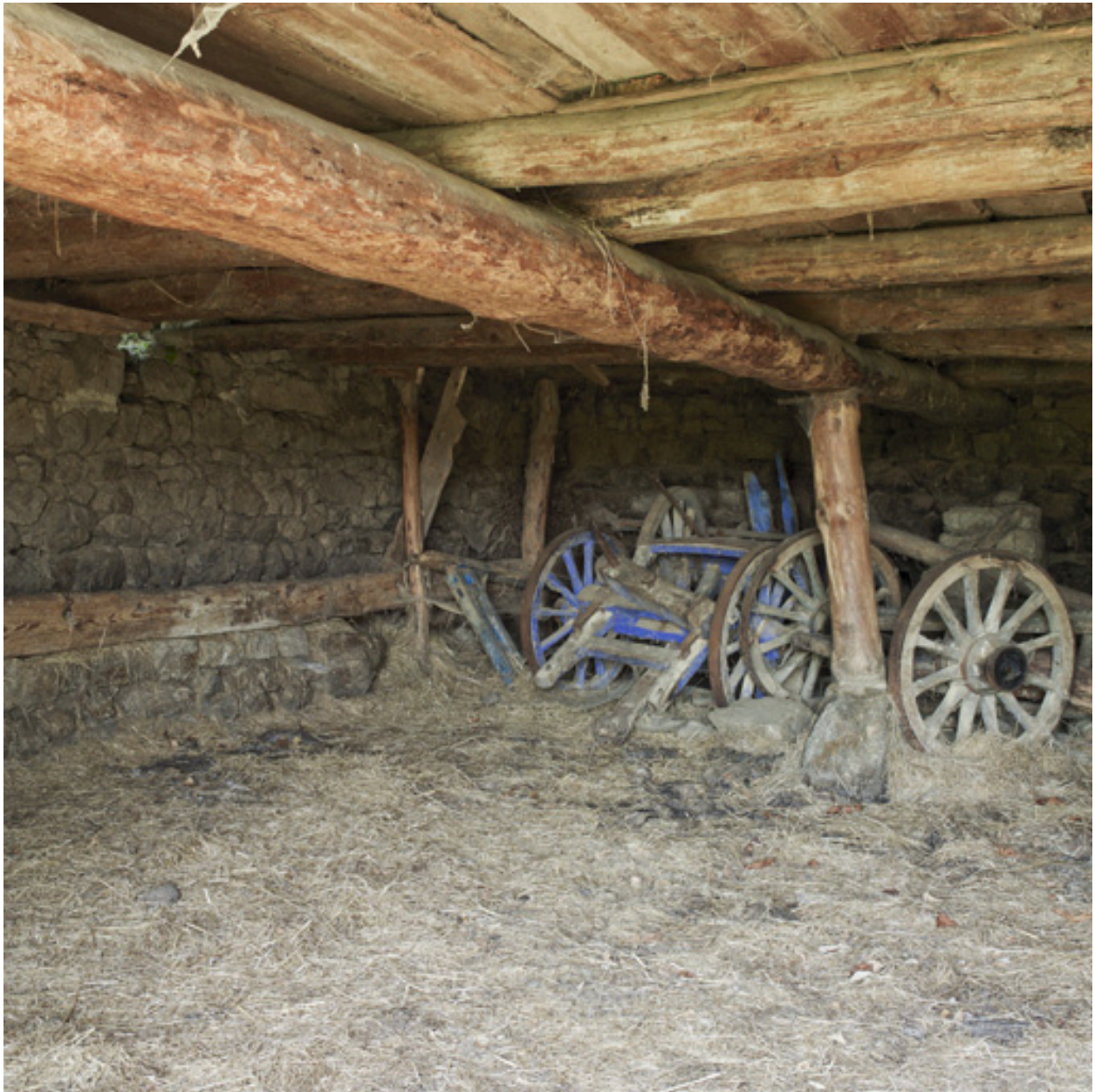
Vue intérieure de l'étable, partie sud.
