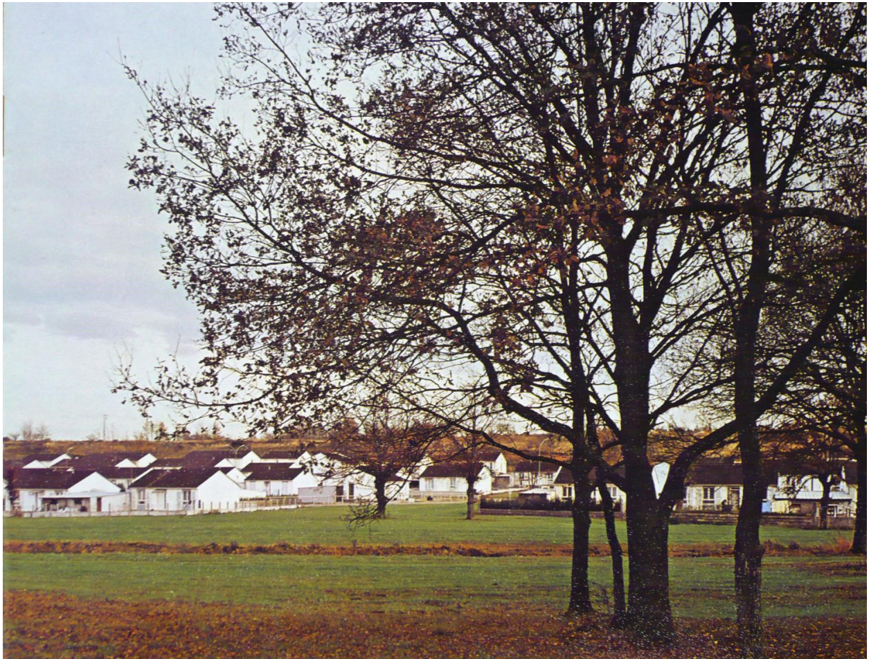
Domérat, lotissement de Bressolles, vue générale depuis le centre du lotissement, en direction de l'ouest, publiée en première de couverture du Bulletin municipal de Domérat, n° 15, 1978.
