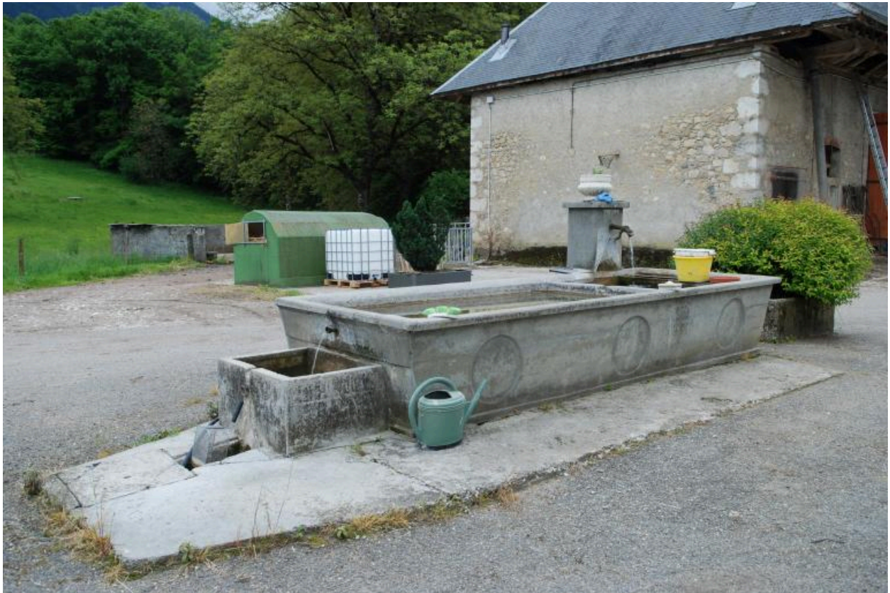
Vue d'ensemble du bassin-lavoir
