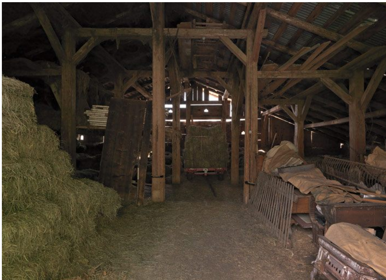
Vue d'ensemble du fenil
