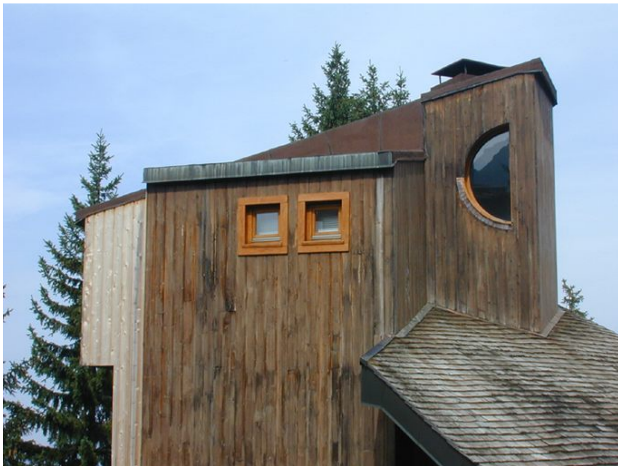
Détail de la cheminée et des ouvertures
